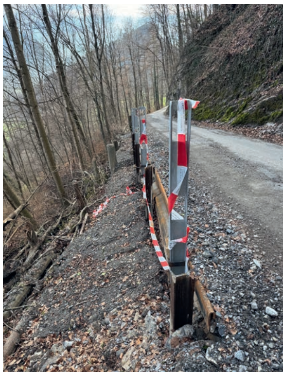
Sanierte Strasse Richtung Valcupp (Teerbelag wird temperaturbedingt im Frühling 2024 eingebaut).
