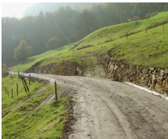
Sanierte Strasse bei Wingglen
