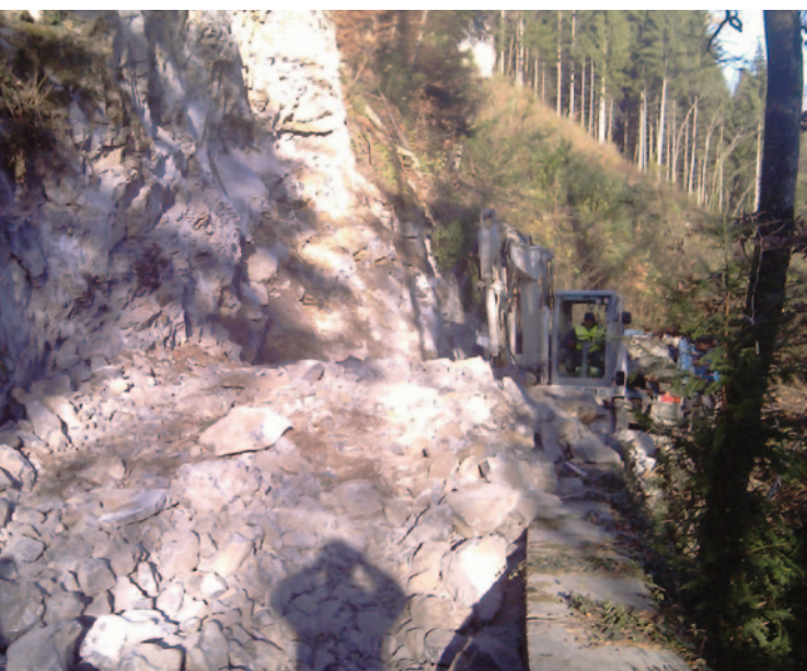
Verbreiterung der Strasse nach Munterdun
