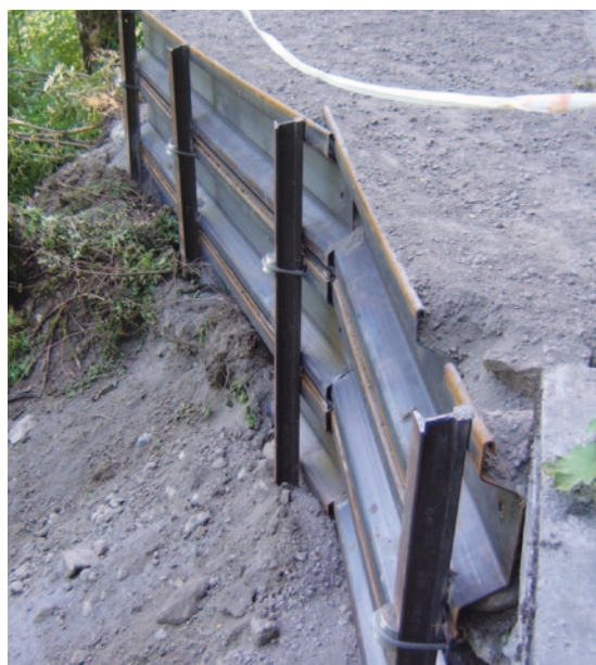
Oberes Tobel: Strassenreparatur mit System «Ribart»
