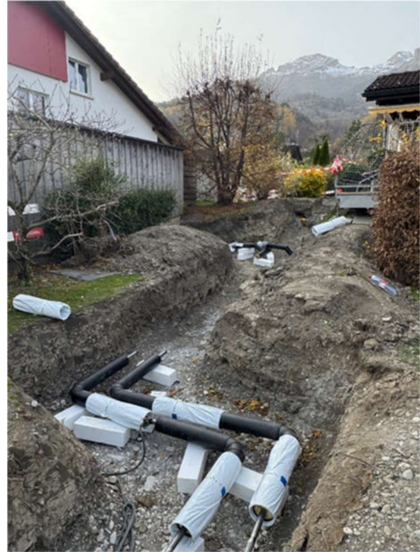
Abgang der Fernwärmeleitung von der Hauptleitung (Bild links) und die Feinverteilung zu den einzelnen Häusern (Bild rechts).
