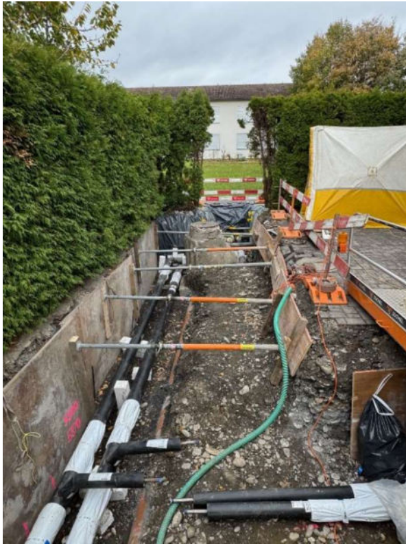
Abgang der Fernwärmeleitung von der Hauptleitung (Bild links) und die Feinverteilung zu den einzelnen Häusern (Bild rechts).
